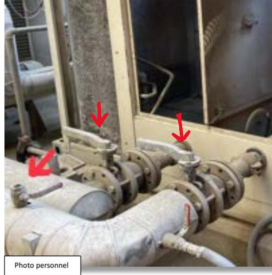
On a ensuite isolé le réseau secondaire en fermant la vanne d'entrée et de sortie, puis nous l'avons vidé à l'aide d'une vanne et d'un tuyau qui faisait office de vidange.
