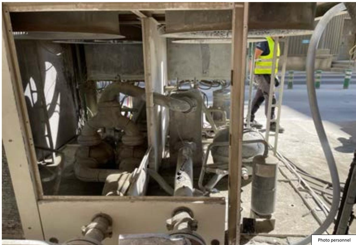
Le problème sur le site est la poussière de ciment qui vient s'incruster dans les ailettes car ce groupe froid sert à refroidir le moteur d'un énorme broyeur.
